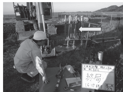
図 13 杭の支持力試験の様子（水平載荷試験）
