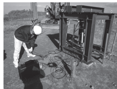
(a) 杭基礎の支持力試験
